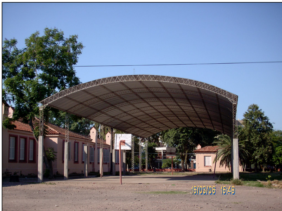
Figura 2-2: Estructura típica con arcos de celosía de barras de sección circular.
