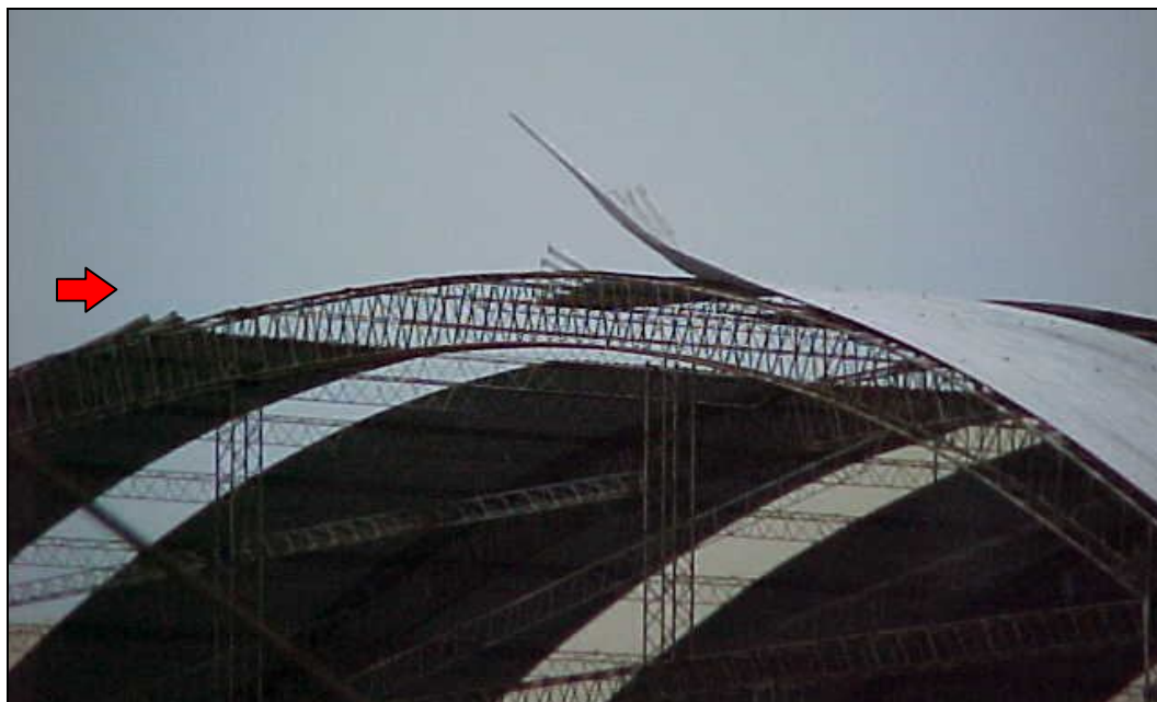
Figura 2-12: Arrancamiento de chapas (C&R) en cubierta aislada, dirección del viento: desde la izquierda, aproximadamente normal a la cumbre.
