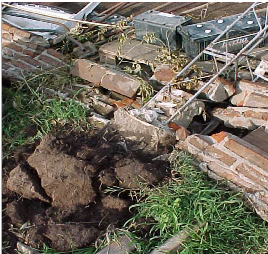
Figura 2-21: Levantamiento de fundaciones (detalle de la Figura 2-20).
