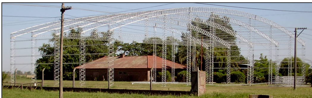
Figura 2-5: Vista de una estructura típica durante su construcción.
