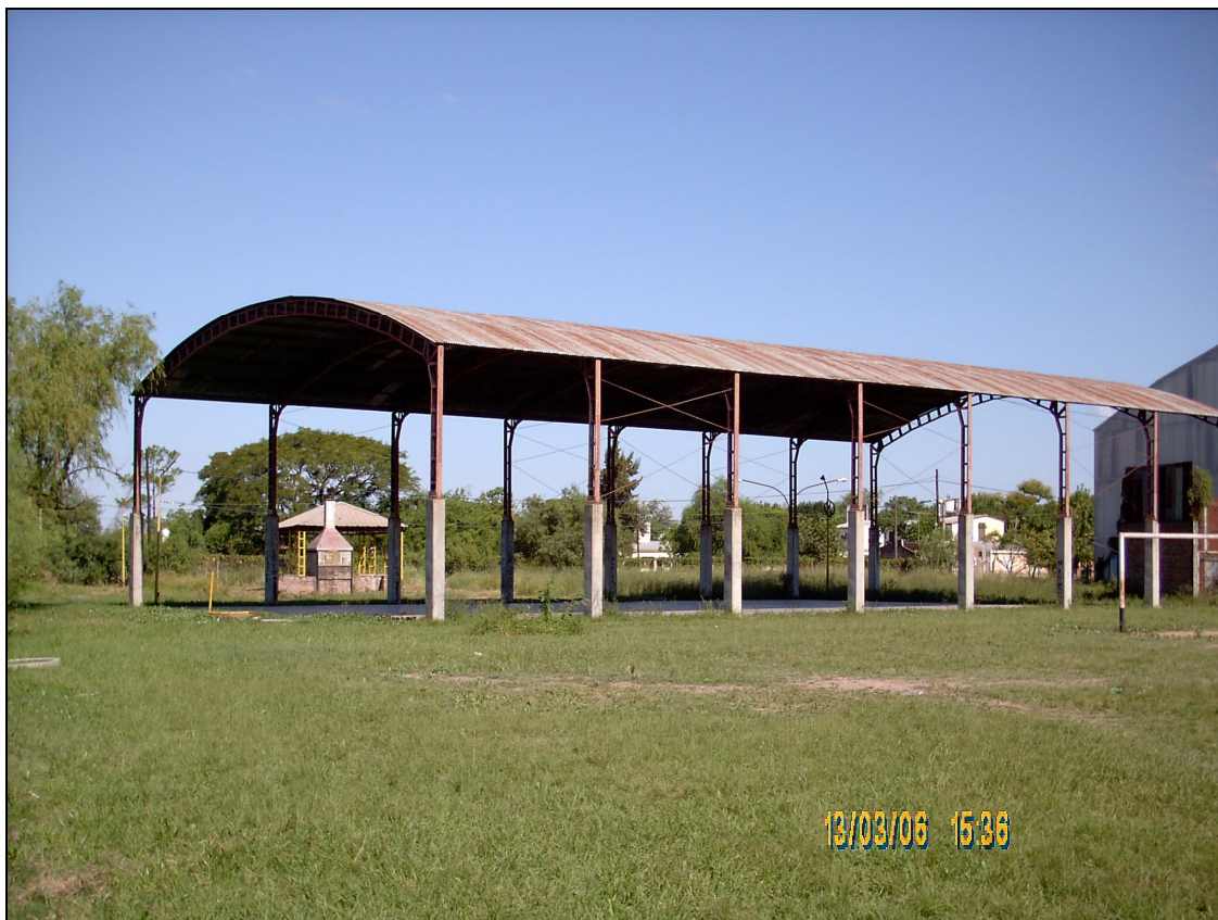
Figura 1-1: Vista de una construcción típica.
