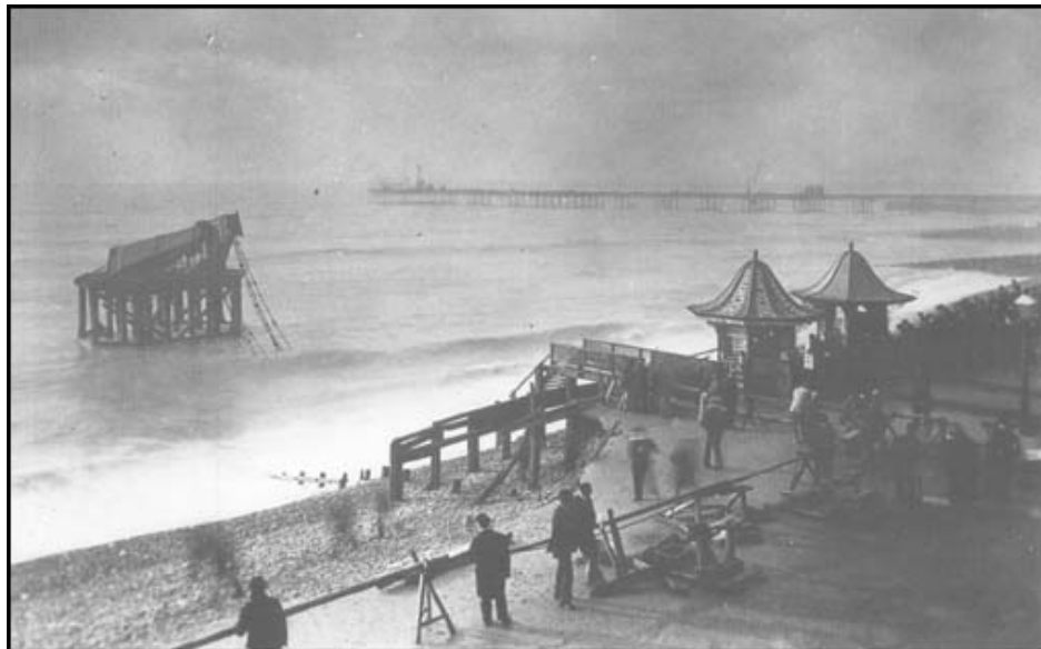
Figura 3-8: El Brighton Chain Pier, después del colapso. Foto A. Sharp.
