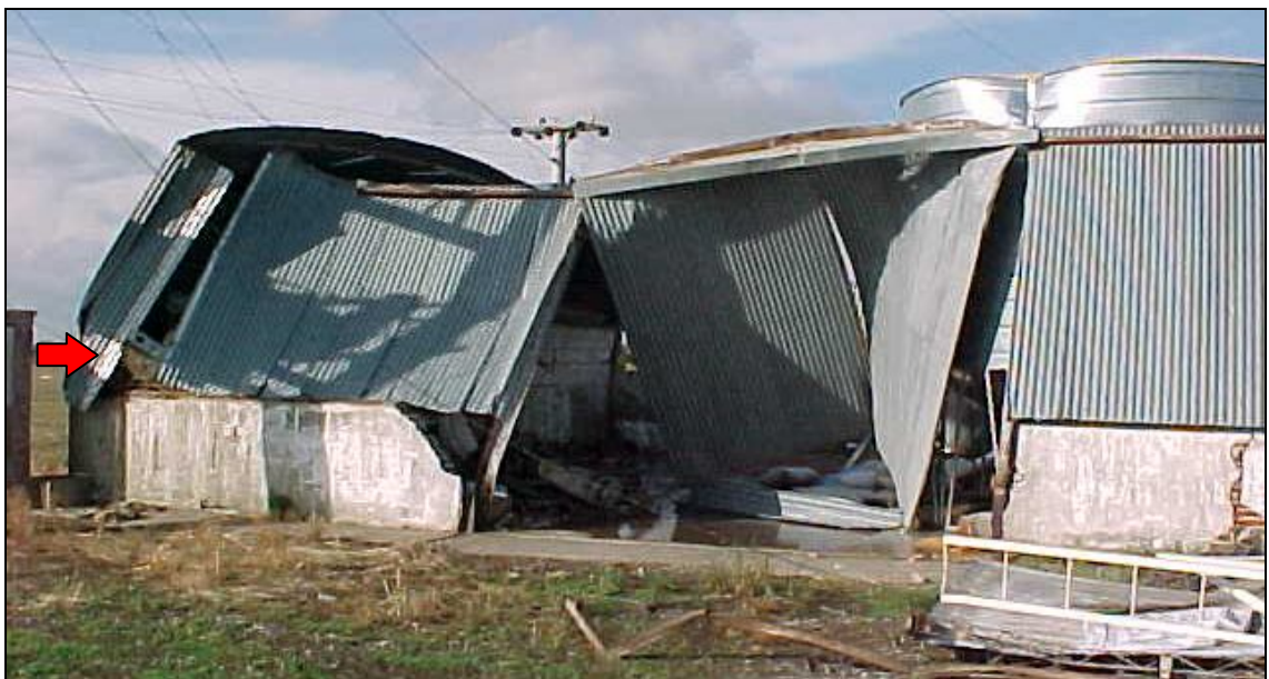
Figura 2-31: Falla de pórtico por esfuerzo horizontal en su plano. Falta de colaboración entre planos resistentes paralelos.
