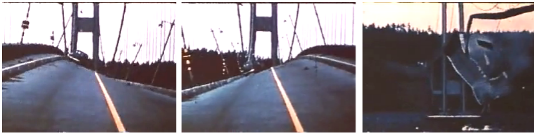
Figure A.2: Colapso del puente Tacoma (1940).
