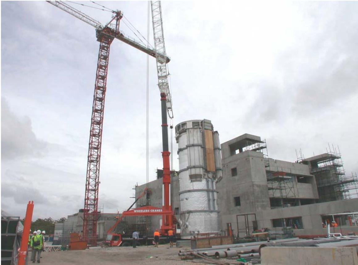
Figura 4: Pileta del Reactor fabricada junto al edificio del reactor
