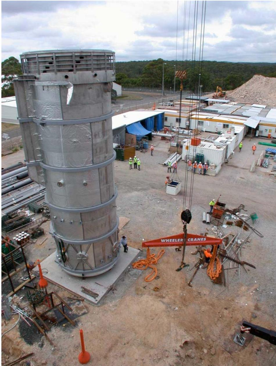
Figura 5: Pileta del Reactor fabricada
