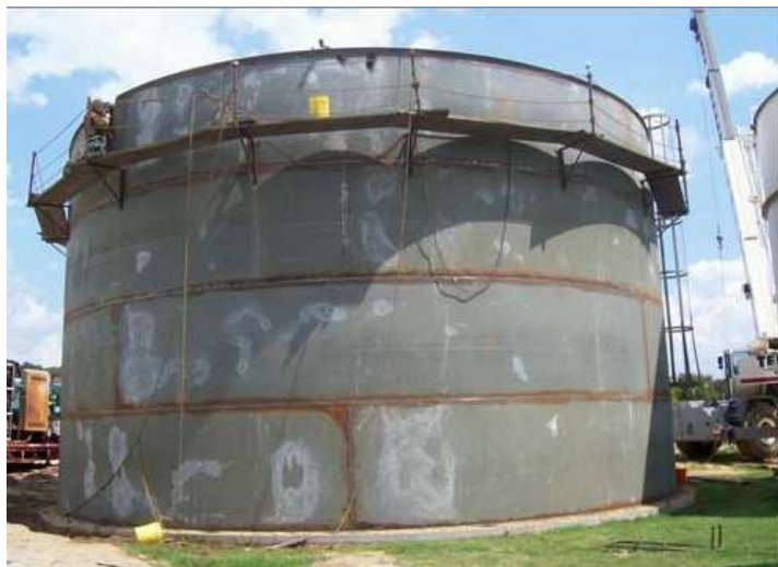
Figura 1: Tanque en etapa constructiva.
