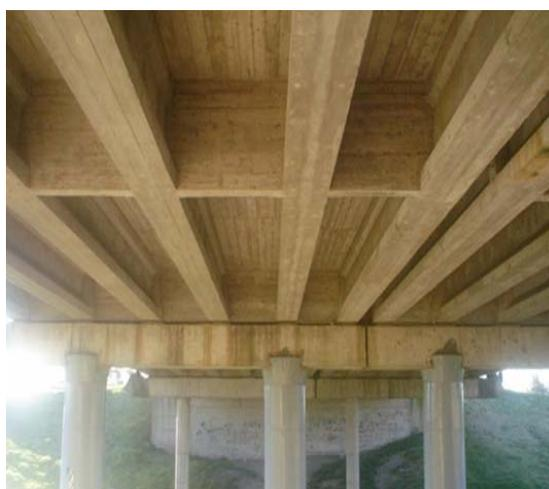
Figura 4: Tipología estructural del Puente Trabajadores
