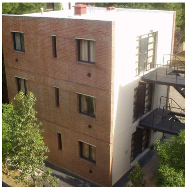
Figura 1a: Vista del edificio aislado
