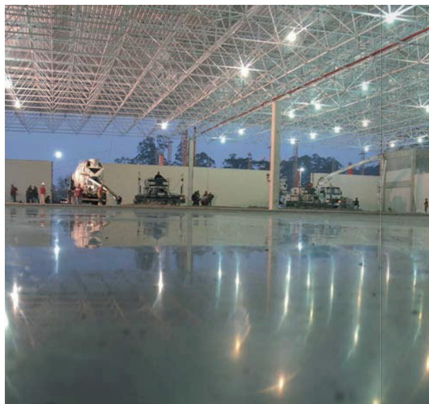
Figura 1: Piso Industrial ( http://www.pisosindustriais.com.br )
