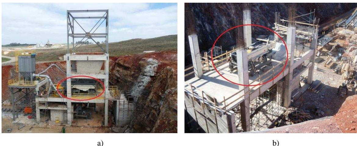
Figura 2: a) Vista general de la estructura durante la etapa de construcción; b) Vista del nivel 178.600 durante la instalación de los equipos de zaranda.
