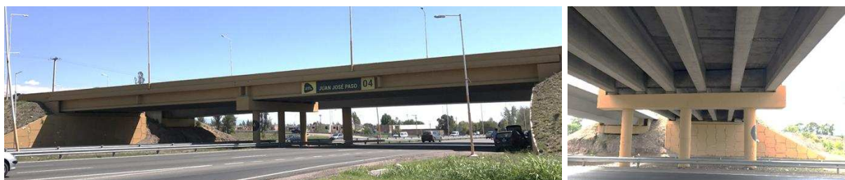
Figura 1: Puente existente en la provincia de Mendoza, Argentina. Intersección de RP10 y RN40.
