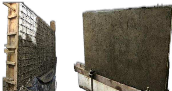
Figura 3: Muro de mampostería con mortero proyectado (en proceso a la izq., y finalizado a la der.).
