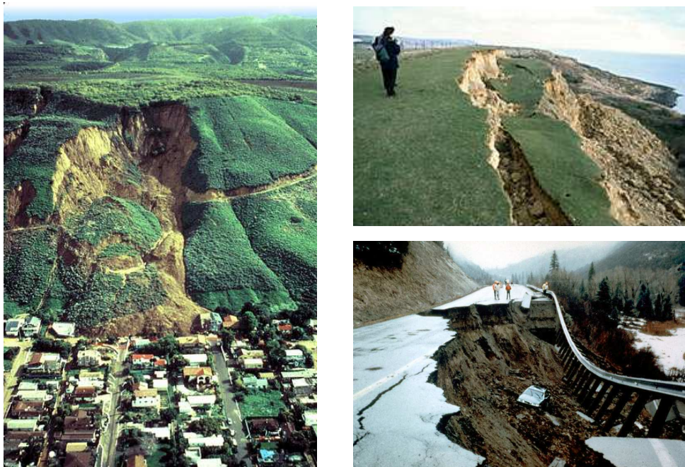
Figura 1.2: Falla masiva debido a inestabilidad en taludes o terraplenes.
